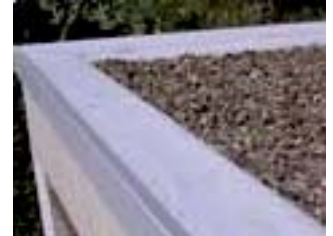
Flachdach mit Kiesfüllung
